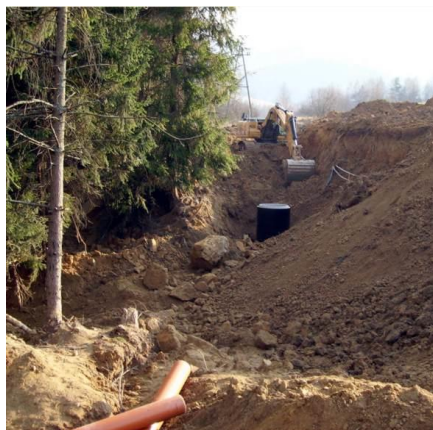
Fot. 2, 3, 4. Przykład budowy kolektora zbiorczego w terenie górzystym.
